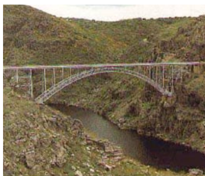
El puente de Pino, estructura metálica de la Escuela Eiffel.
